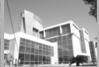
Çimentaş Sosyal Hizmet Binası
