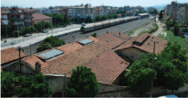
TCDD Hangar Binası
