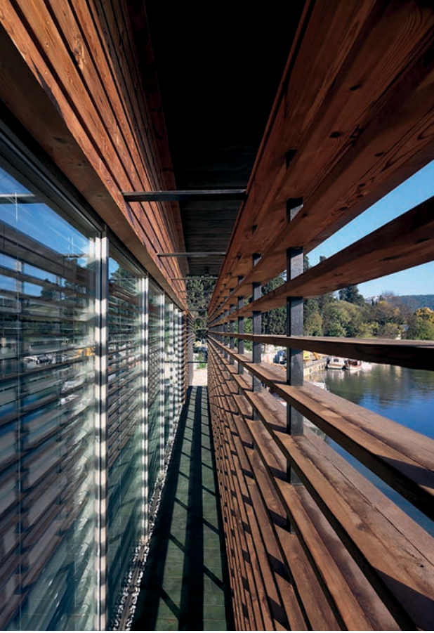
ÜSTTE Göksu Ofis Yapısı ön cephe sistemi. (Emden, 2010) (Görsel 7).
