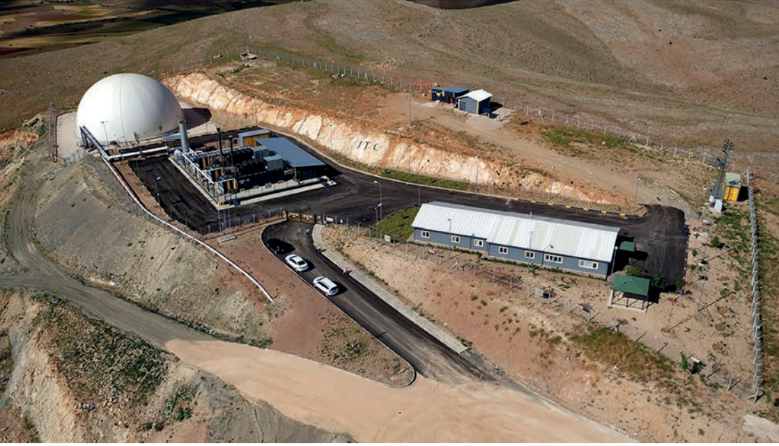
SOLDA Atıktan Enerji Üretim Tesisi. Kaynak: Elâzığ'da çöpten..., 2021. (Görsel 6)
