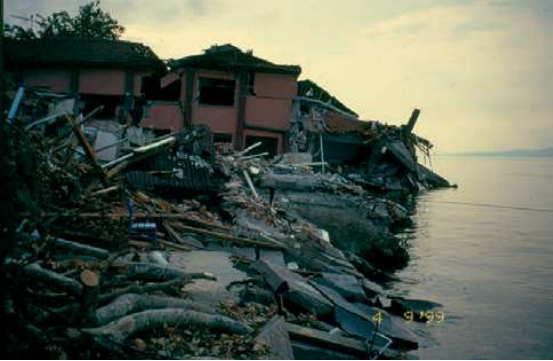
ÜSTTE, SAĞ ÜSTTE 1999 Marmara depreminden yıkılma neden olan ağır yapı hasarları (Nilüfer Akıncıtürk arşivi).
