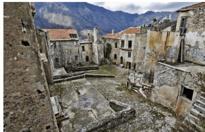
Fiziksel Yapı Hasarları
