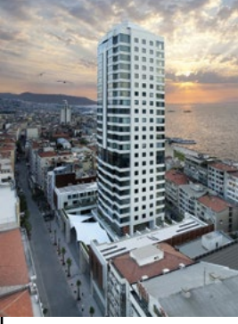
The Port Rezidans, Alsancak, 2010; URL-7 (Kar İnşaat)
