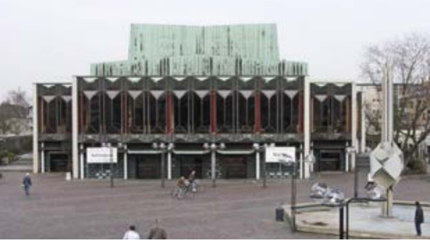
Krefeld Şehir Tiyatroları, Giriş Cephesi, 1960
