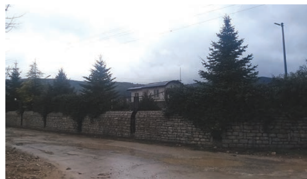
ÜSTTE Yeni yapılar: Üretim yapıları ve depolar (Şekil 16)
