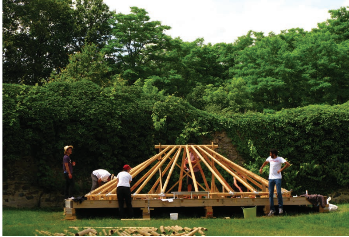
SOLDA ÜSTTE Shigeru Ban'ın kağıttan borularla inşa edilen pavyonunun yapım aşamasından; Boisbuchet'nin sebze bahçesinde yer almaktadır; 2001
