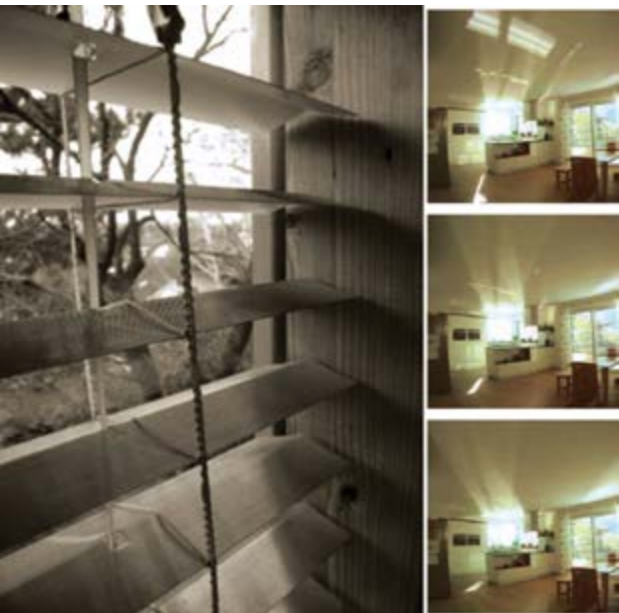
ÜSTTE Aynalı jaluzi sistemi (BNP Paribas, Paris, Fransa) ve RETROLux O/ RETROLux U için bir sistem kesiti (400' lik güneş açısı ile yönlendirme) (Köster Katalog, 2016). (Resim 1)
