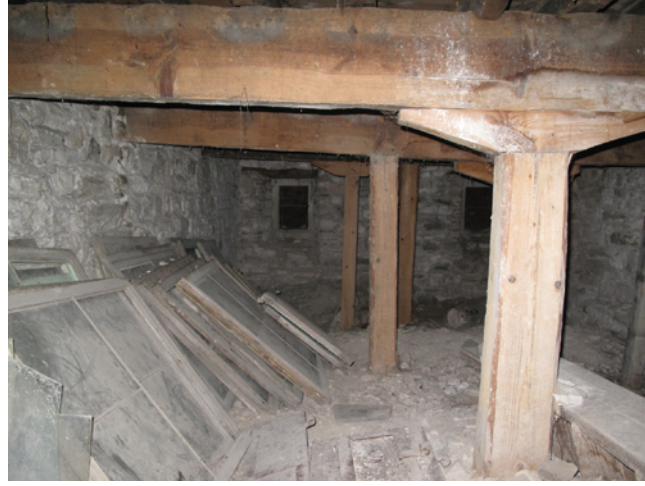
SOLDA Bodrum kat (Resim 10)
