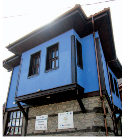
SOLDA Avlulu ev örneği (Köşklük Kaya, 2012) (Resim 6)
