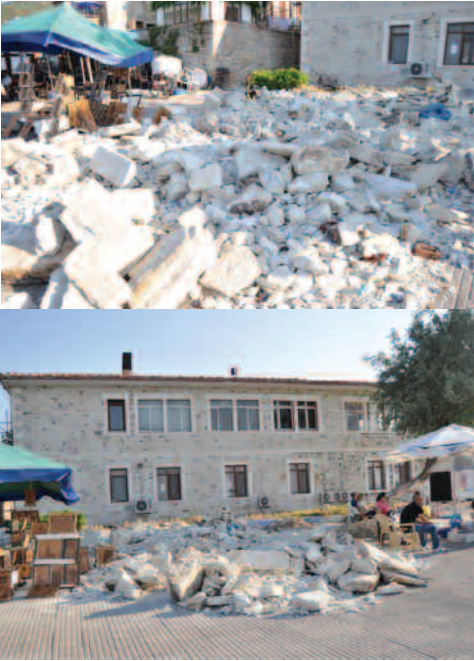
ÜSTTE Bina yenilemede, eski yapılardan elde edilen “Taş”ın kullanılması, Yeni Foça (Resim 1)
