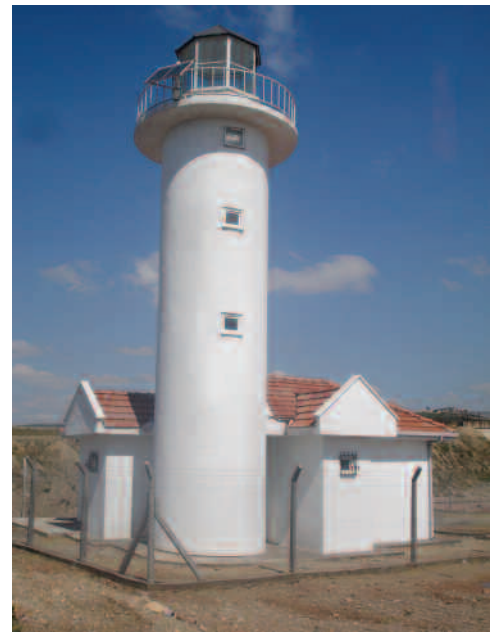
ALTTA Betonarme yapılmış tekniğinde inşa edilen Kavaburnu Feneri, (2010) (Resim 7)
