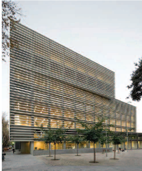
SOLDA Barcelona Poublenou Bölgesi Mimari
