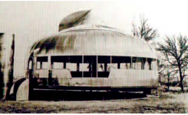
Dymaxion Evi -montajı bitmiş halde: tüm malzemeler, resmin sol tarafındaki tüpün içinde taşınıyor (Hays & Miller, 2008, s. 119) (Sieden, 1989, s. 277) (Resim 1)
