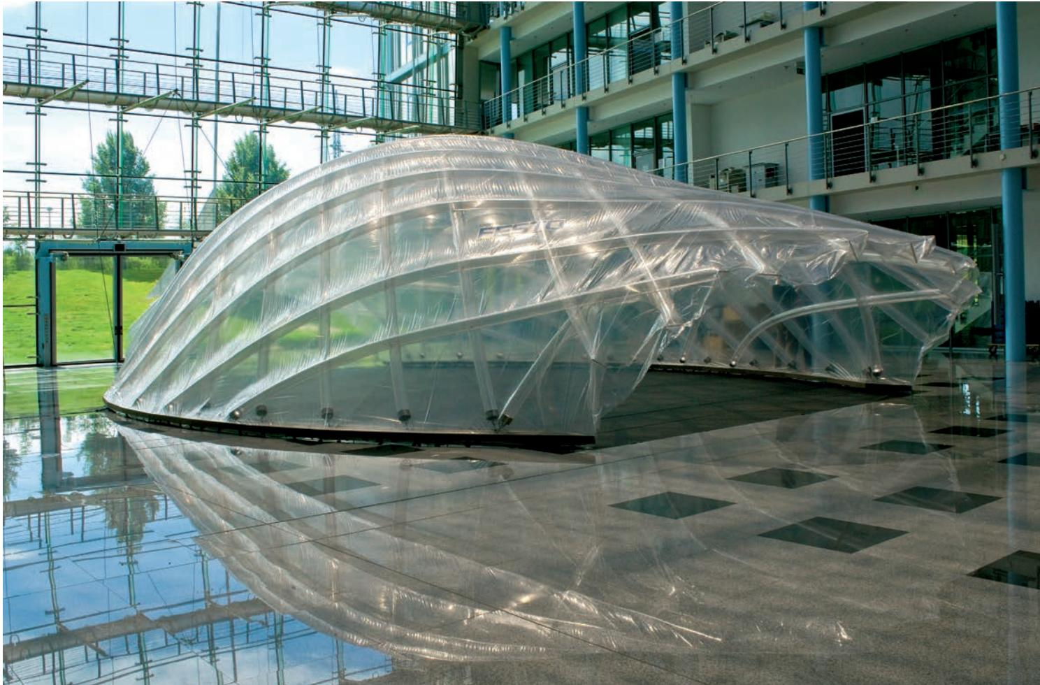
sönümlenip tekrar aktif hale getirilebilmesini de sağlar. ILEK tarafından geliştirilmiş "Artı-Eksi Sistem" bu yaklaşımın başarısını sergiler (Resim 9). Vakum ile stabilize edilmiş folyo çubuklar, bağımsız bileşenleri tek bir sistemde toplayıp sistemi sertleştirirken, taşıyıcı çubuk elemanlar yüksek basınçla stabil hale gelir. Strüktürel eleman olarak havayı kullanan bu tasarım, hem bir fuar standı hem de bir kabuk strüktür olarak ILEK tarafından gerçekleştirilip üretilmiştir.
