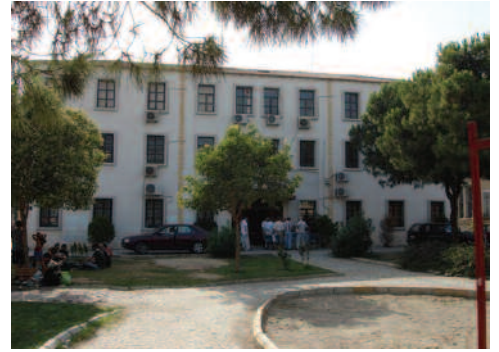
ÖSYM binasının yerinde eskiden mevcut olan betonarme bina
