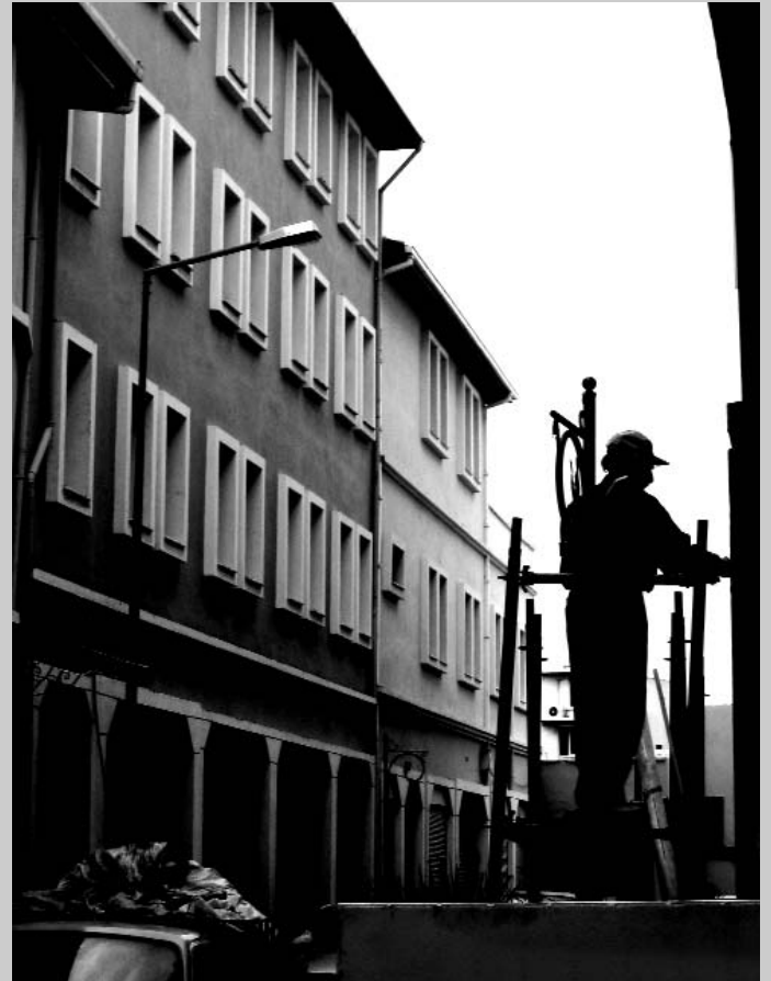
Izmir 926 Sokak'ta belediye - esnaf işbirliği ile yürütülen iyileştirme çalışmaları
