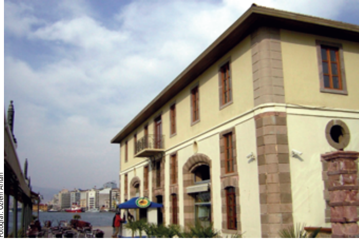
Konak Pier Alışveriş Merkezi, batı cephesi (restorasyon sonrası)
