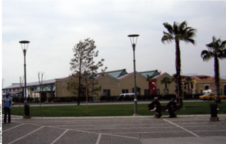
Konak Pier Alışveriş Merkezi, doğu cephesi (restorasyon sonrası)
