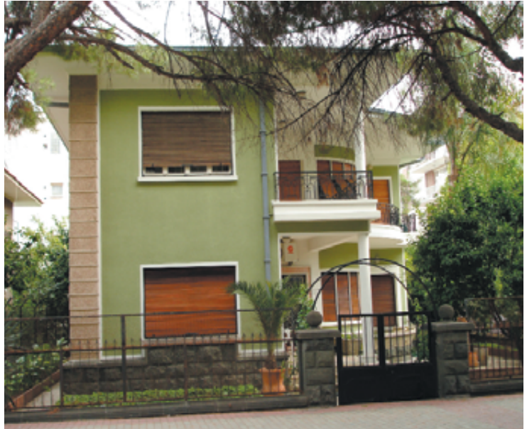
Süller Villası Mimar Fahri Nişli Parsel No:43
