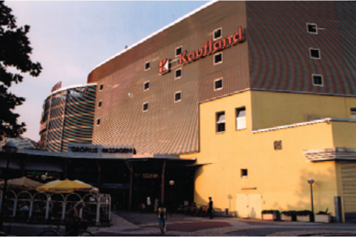
Gropiusstadt dönüşüm projesi
