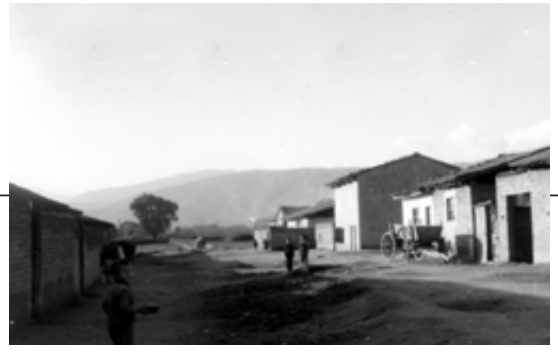
Türkmen Mahallesi Yeşil Sokak (Doğuydan Batıya)
