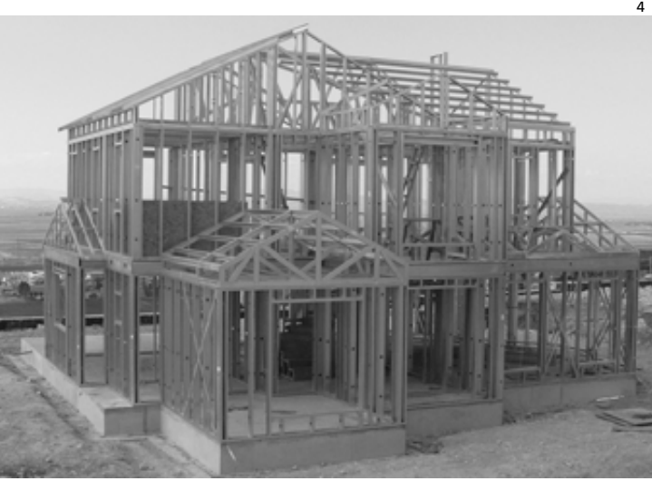
İzmir Ulukent'te uygulanan Cordelia evinin yapı sistemi
