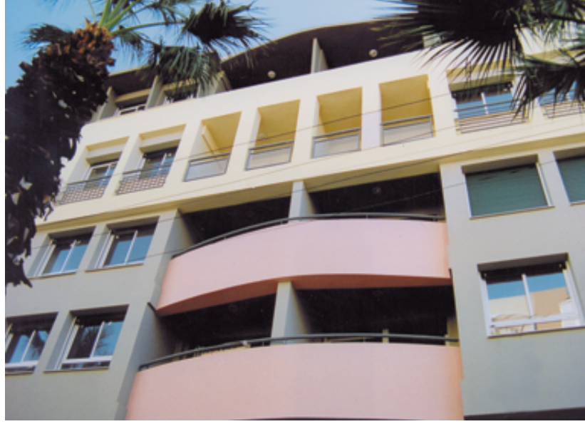
Sevinç Hanım Apartmanı ön cephe detayı
