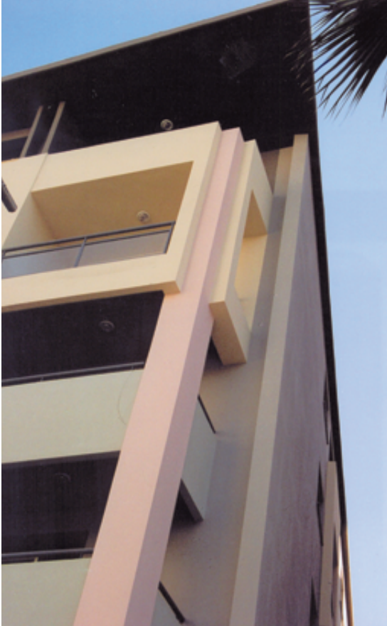
Sevinç Hanım Apartmanı köşe detayı
