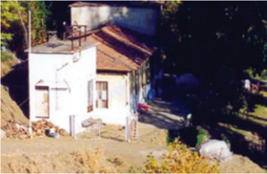
1934 yılında kurulan Ödemiş Elektrik Santrali'nden görünüş
