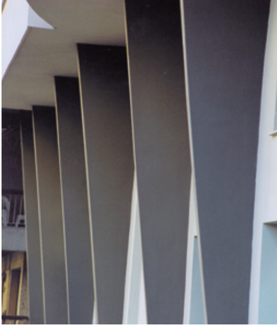
Sevinç Hanım Apartmanı ön cephede çağdaş payanda yorumu
