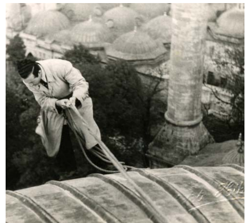
Beyazid Camii kubbe onarımı
