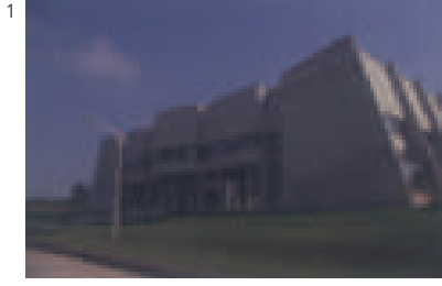
Uludağ Üniversitesi Mühendislik Mimarlık Fakültesi, Mimarlık Bölümü Binası
