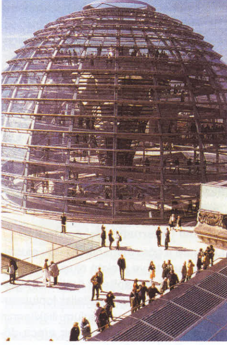
Norman Foster'ın Reichstag için tasarladığı kubbe. Son yılları en çok konuşulan yapılarından olan bu kubbe hem mekansal olarak hem de yapı ve çevresi ile kurduğu ilişkiler açısından eleştirel bir nitelik taşımaktadır.
