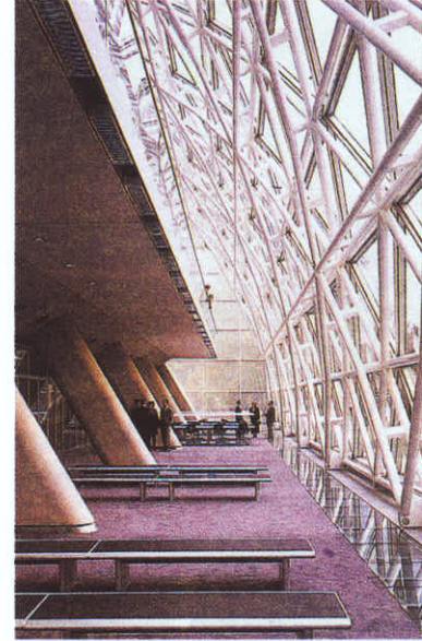
Cambridge, Yeni Fakülte Binası Mimarlar: Sir Norman Foster and Partners, Londra Taşıyıcı sistem tasarımcıları: YMR Anthony Hunt Associates
