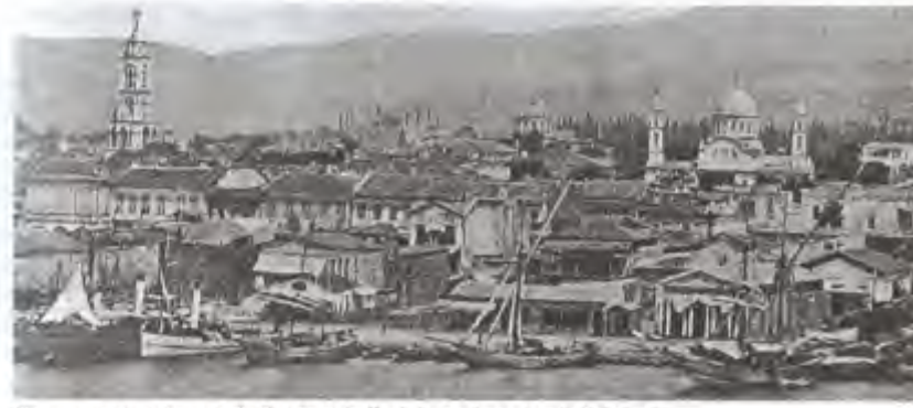
Limanın yapımı öncesinde Frenk mahallesi'nin deniz cephesi görünümü
