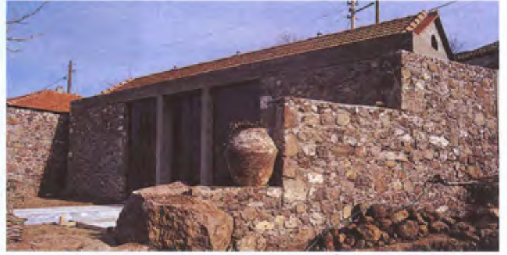
Taşlık bir araziden toplanan ve hafriyattan çıkan ve eski yapının yıkımından elde edilen taşlar kullanıldı.
