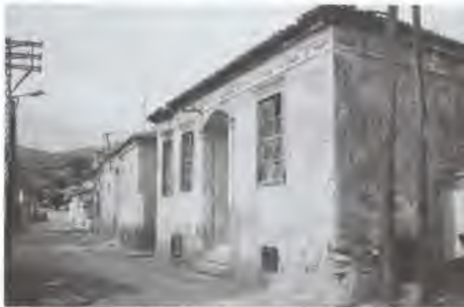
Gündoğdu Caddesi'nde yıkılacak yapılar
