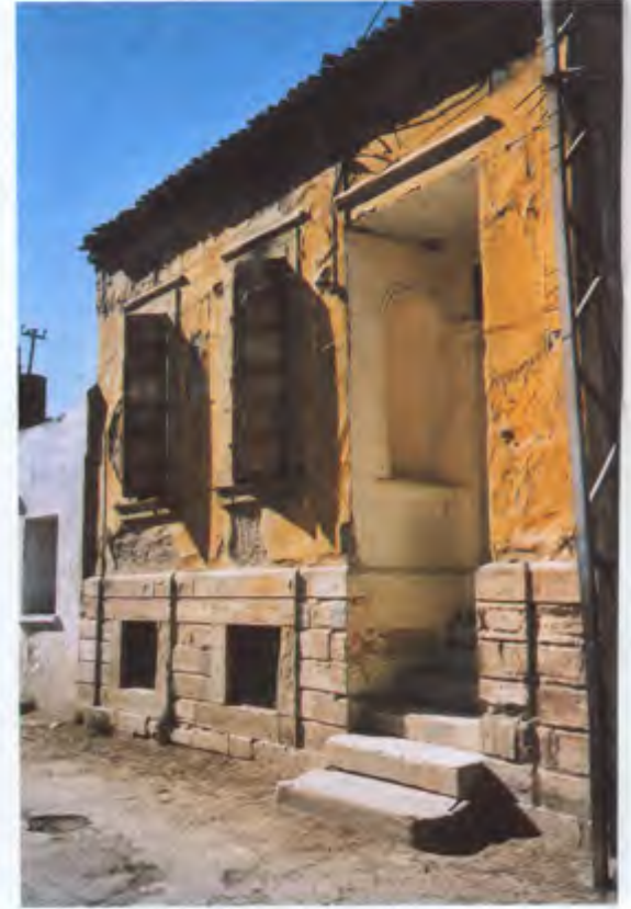
Gündoğdu Caddesi'nde yıkılacak bir yapı
