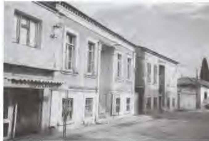
Gündoğdu Caddesi'nde yıkılacak yapılar
