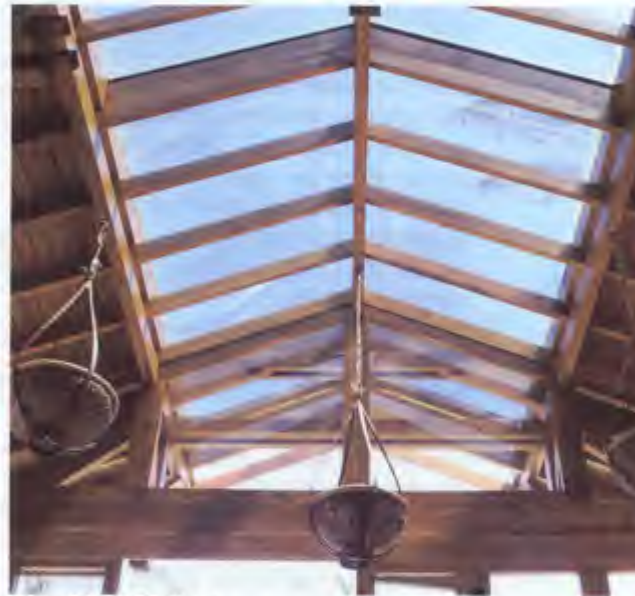
Queen Ada Otelin Bodrum. Ahşap Çatı Konstrüksiyonundan detay
