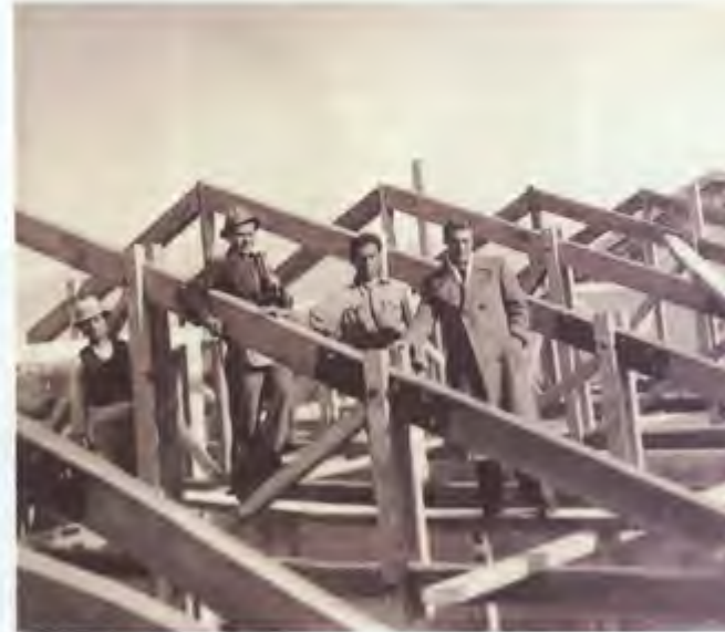
Garaj çatısı inşaatında
