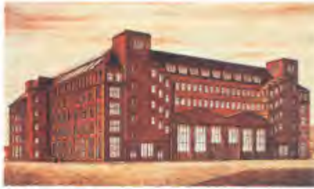
AEG Yüksek Gerilim Tesisi, P. Behrens, Berlin, 1909
