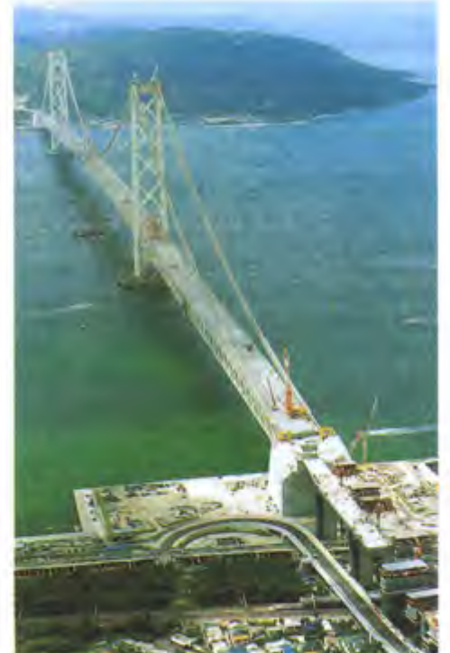
Akashi Kaikyo Bridge Kobe şehri ile Awaji Island arasında inşa edilen dünyanın en uzun asma köprüsüdür. Hem demiryolu, hem de karayolu olarak hizmet veren köprünün ayakları arasındaki mesafe 1990 mt dir. Ayrıca, köprünün altına kurulan müzede, gerek bilgisayar oyunları gerekse maket ve çizimlerle köprü ve dünyadaki diğer asma köprüleri hakkında tüm bilgiler yer almaktadır.
