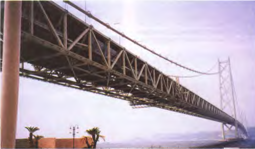
Akashi Kaikyo Bridge Kobe şehri ile Awaji Island arasında inşa edilen dünyanın en uzun asma köprüsüdür. Hem demiryolu, hem de karayolu olarak hizmet veren köprünün ayakları arasındaki mesafe 1990 mt dir. Ayrıca, köprünün altına kurulan müzede, gerek bilgisayar oyunları gerekse maket ve çizimlerle köprü ve dünyadaki diğer asma köprüleri hakkında tüm bilgiler yer almaktadır.
