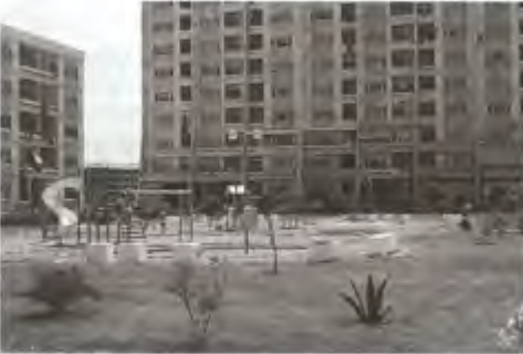
Atakent - Çocuk Bahçesi (!)
