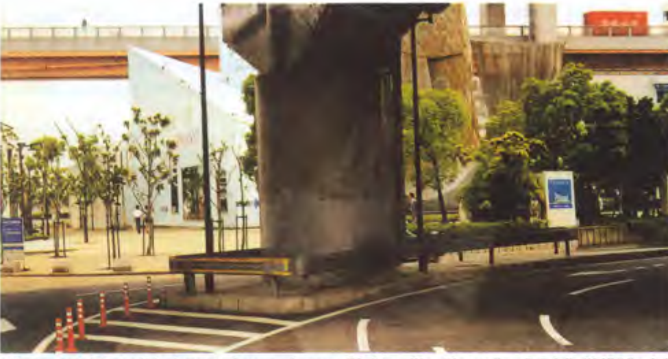
17 Ocak 1985 tarihinde meydana gelen ve Richter ölçeğine göre 7.2 büyüklüğündeki Kobe Depreminden sonra, yıkılan yapılar yeniden yapılmış ve hasar gören yapılar yenilenerek sağlamlaştırılmıştır. Yukarıdaki resimde, çelik kaplanarak yenilenen, köprü ayağı görülmektedir.
