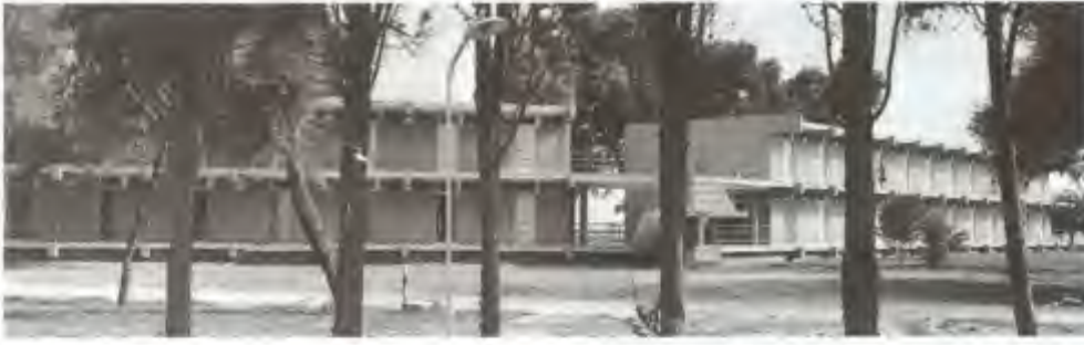
T. Emlak Kredi Bankası imar bürosunda, proje ve uygulamada kontrollüğünü yaptığı Ataköy Plajı kamping ve motel
