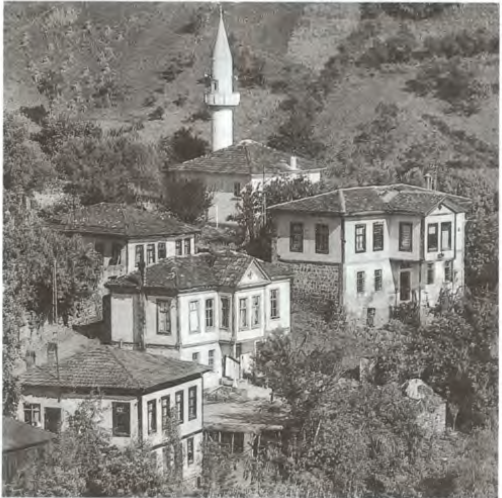
Akçaabat, Çolaklı Mahalle, son beş yılda bozulan doku
