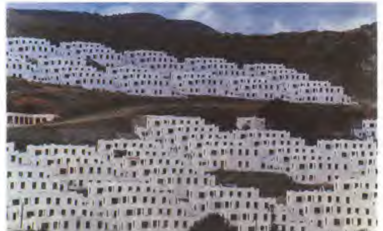
Bodrum, parsel büyüklüğü ve yoğunluk ilişkisi kurulmamış yapılaşma
