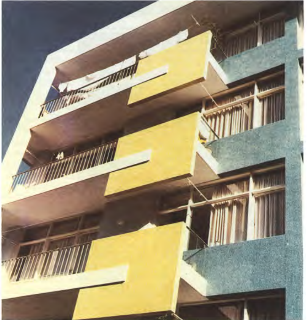
Bir apartman cephesinden detay
