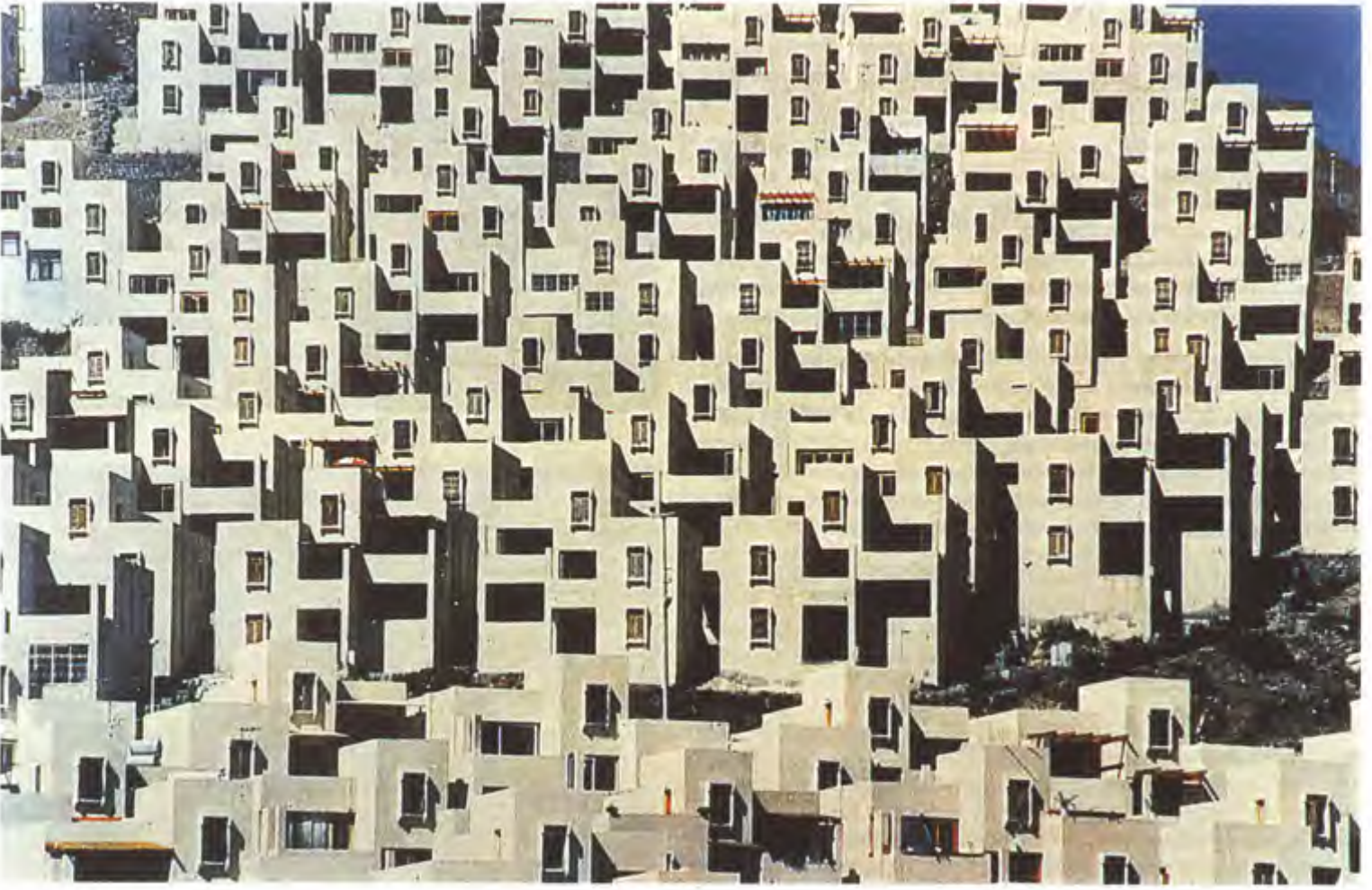
Bodrum, 2. konut yerleşmesi
