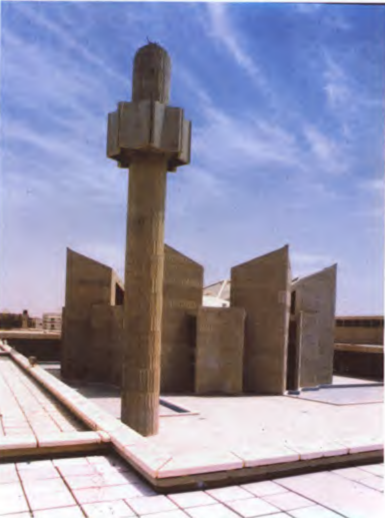
Cidde'de brüt beton camii
