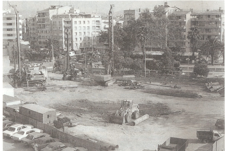
Katlı otopark alanında inşaat faaliyetleri (Eylül ortası)
