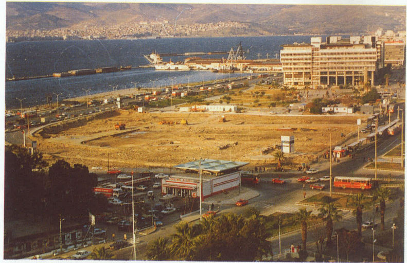
Konak Meydanında Galleria İnşaatı
