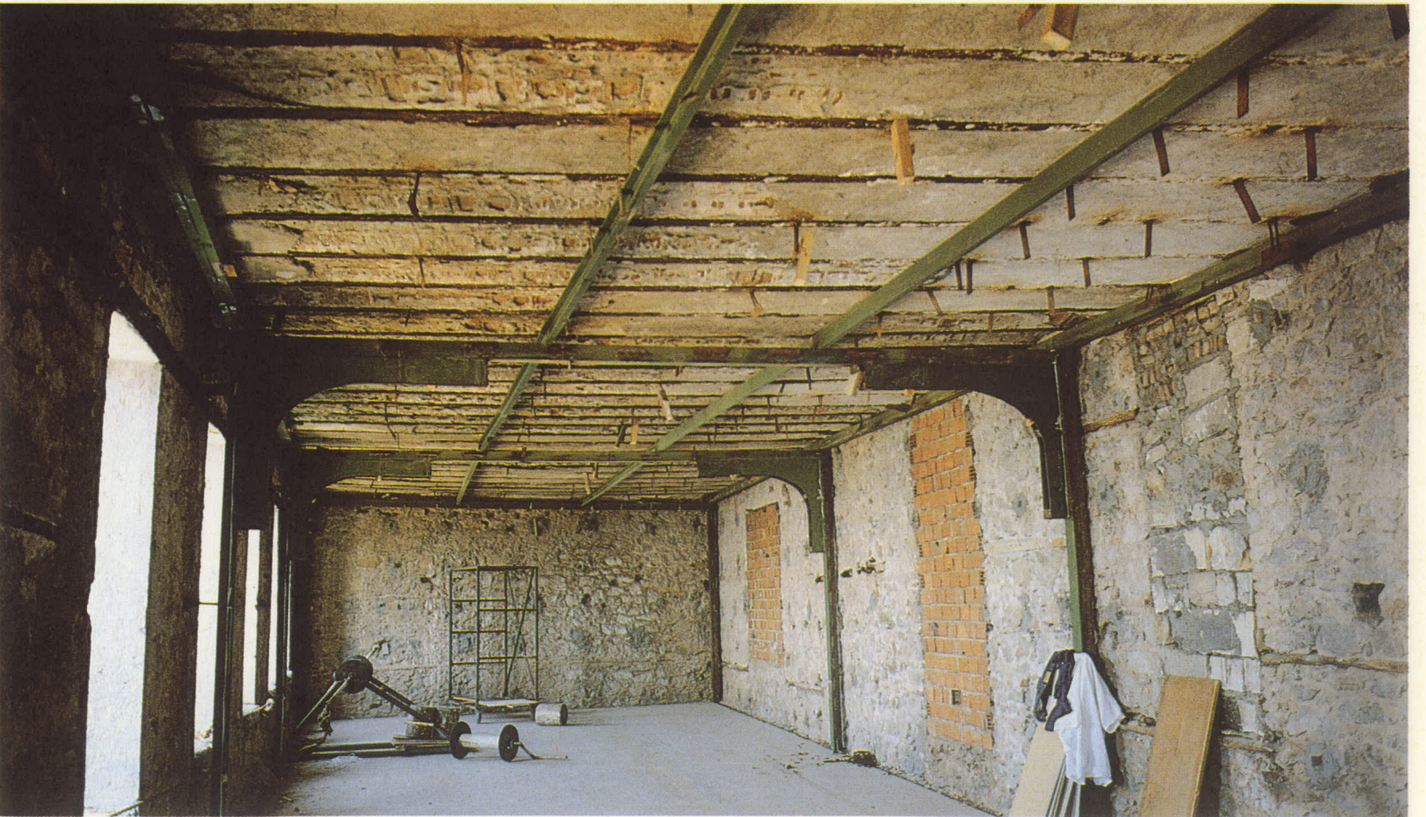
Yıllarca putrellerleayakta tutulabilen eski volta döşeme.
