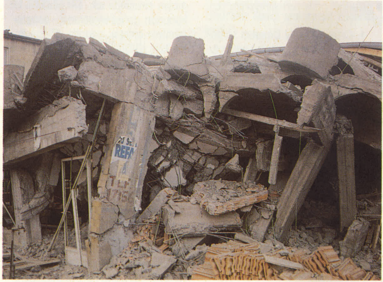
Düğüm noktalarındaki hasar
