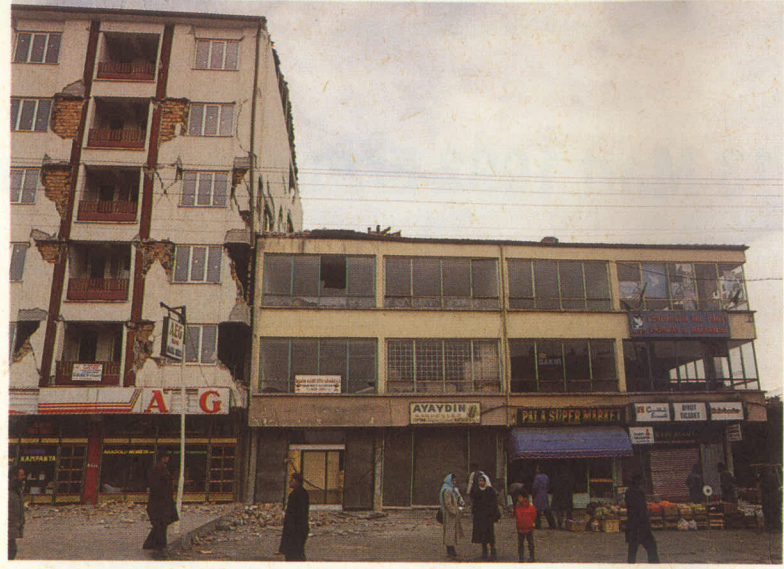
Komşu binanın sebep olduğu zarar ve dilatasyonun yararı
