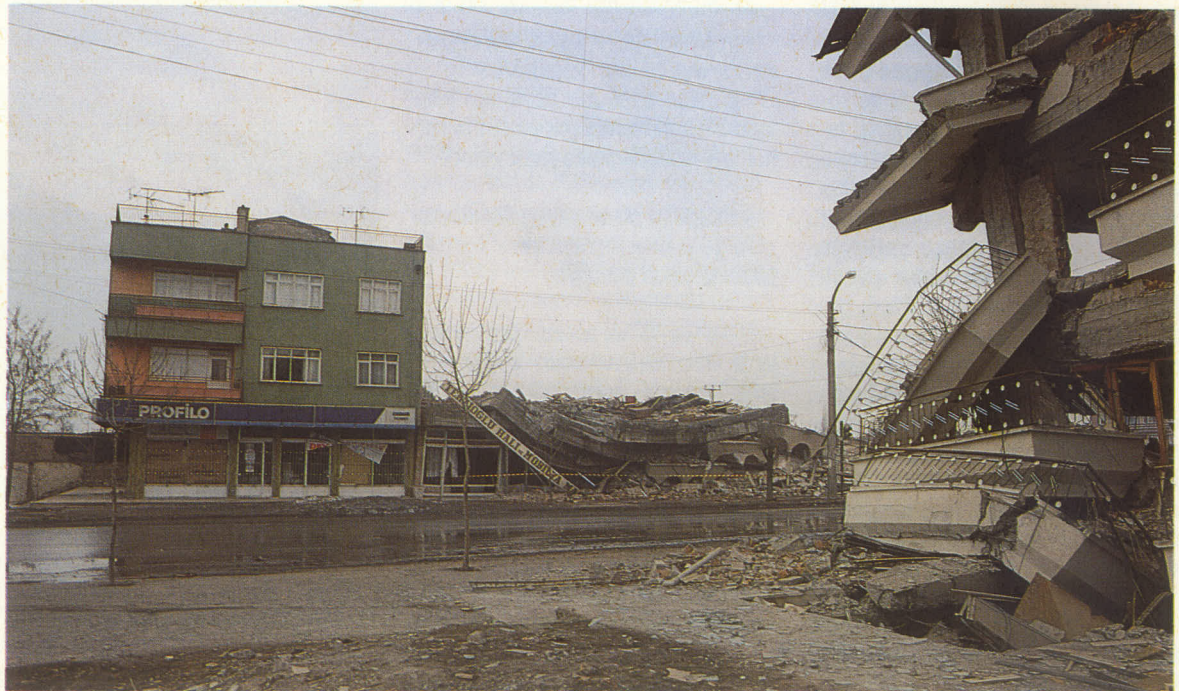
Komşusu yerle bir olduğu halde kendisi ayakta kalan (Kurallara uygun yapılan) bir bina
