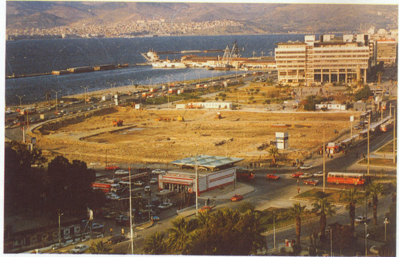
Konak Meydanında Galleria İnşaatı
