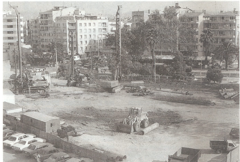
Katlı otopark alanında inşaat faaliyetleri ( Eylül ortası)
