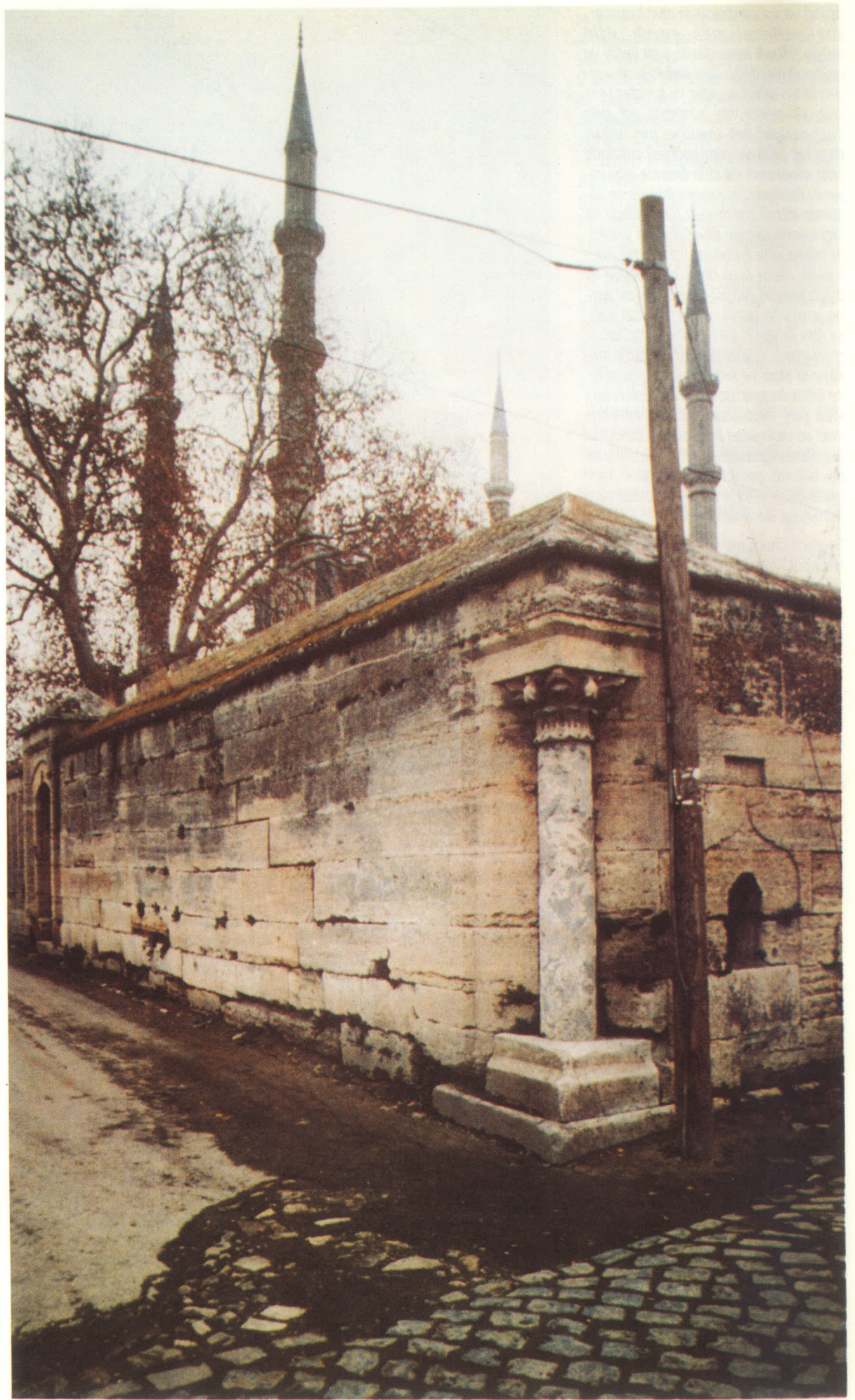
Sinan'ın Selimiye'nin dış duvarı köşesine açtığı özel nişe yerleştirdiği kolonun önüne 50cm. ötesine dikilen posta direği... Kim daha kültürlü? Sinan mı, dörtüyz yıl sonraki sözüm ona teknik adam mı?...
