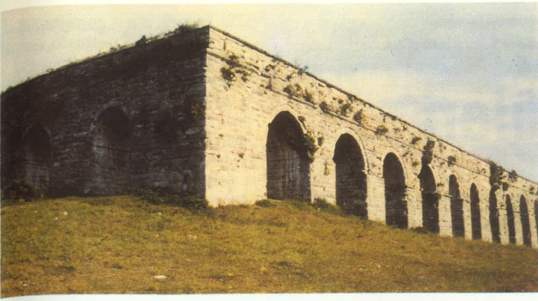
Şekil 9 : Kırkçeşme suyunun doğu kolu üzerinde Eğrikemer'in dirsek kesimi (foto: Ü.Öziş).
