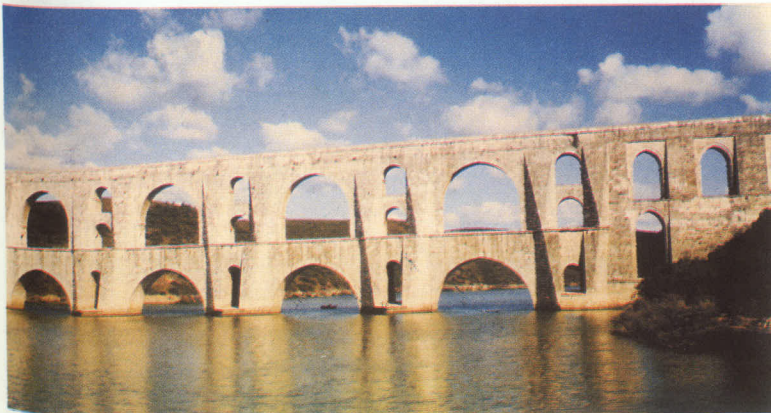
Şekil 11 : Kırkçeşme suyu kolu üzerinde Mağlova kemeri (foto Ü.Öziş).
