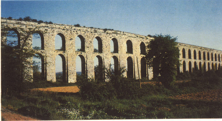
Şekil 8 : Kırkçeşme suyolunun batı kolu üzerinde Uzunkemer (foto: Ü.Öziş).
