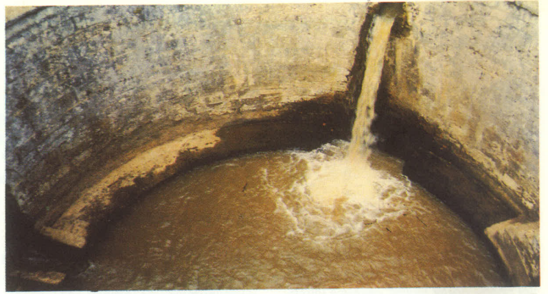
Şekil 10 : Kırkçeşme suyolunda iki kolun birleştiği Başhavuz (foto: Ü.Öziş).
