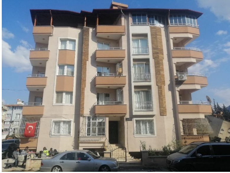
Hiç hasar almayan – sıva çatlağı bile bulunmayan binalar
