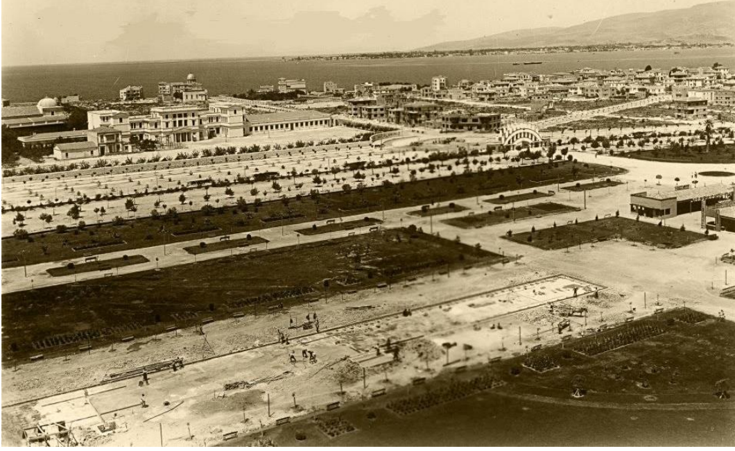
Kültürpark, inşa edilirken.
