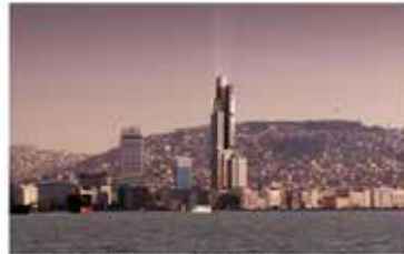
45 katlı gökdelen için verilen yapı ruhsatına dava
