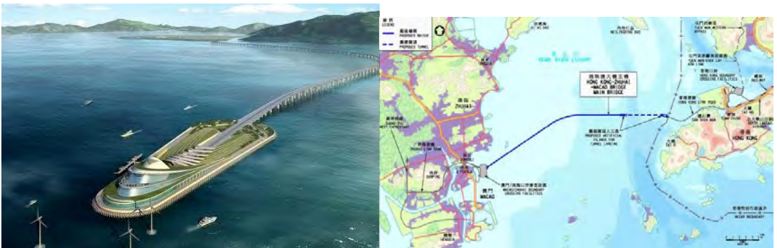
Şekil 15. Zhuhai HKMZ Köprü Tünel Projesi
