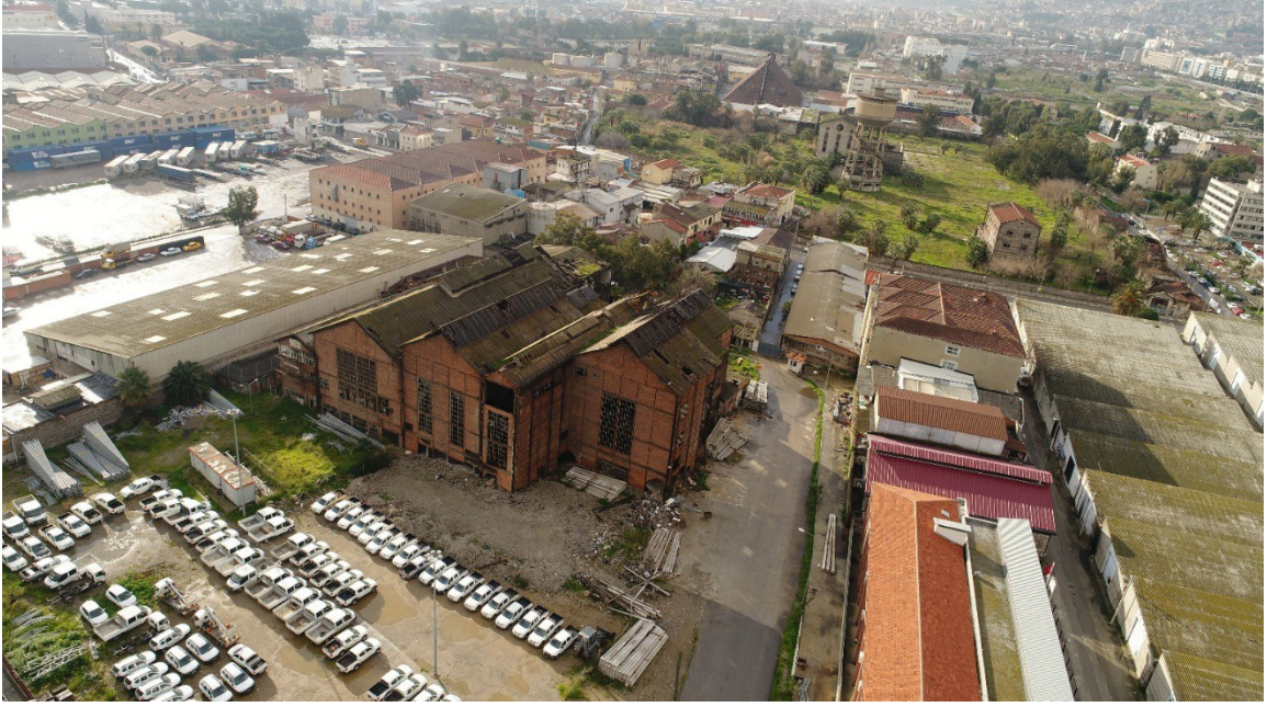
Resim3. Elektrik Fabrikası'nın mevcut durumu
