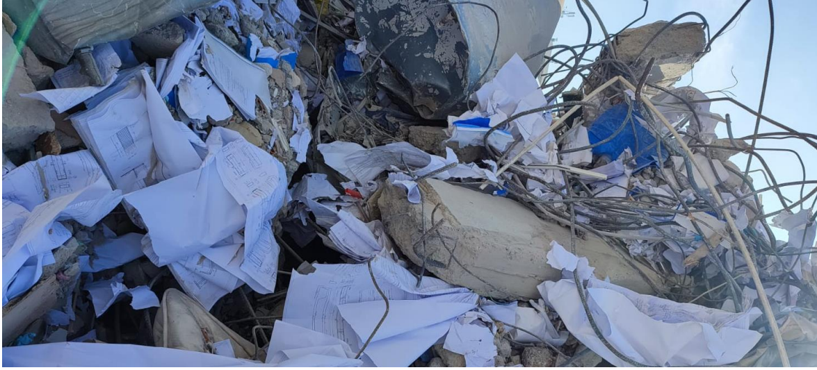
Fotoğraf: Kahramanmaraş Kent Merkezinde bulunan bir mimarlık ofisinin enkazı
