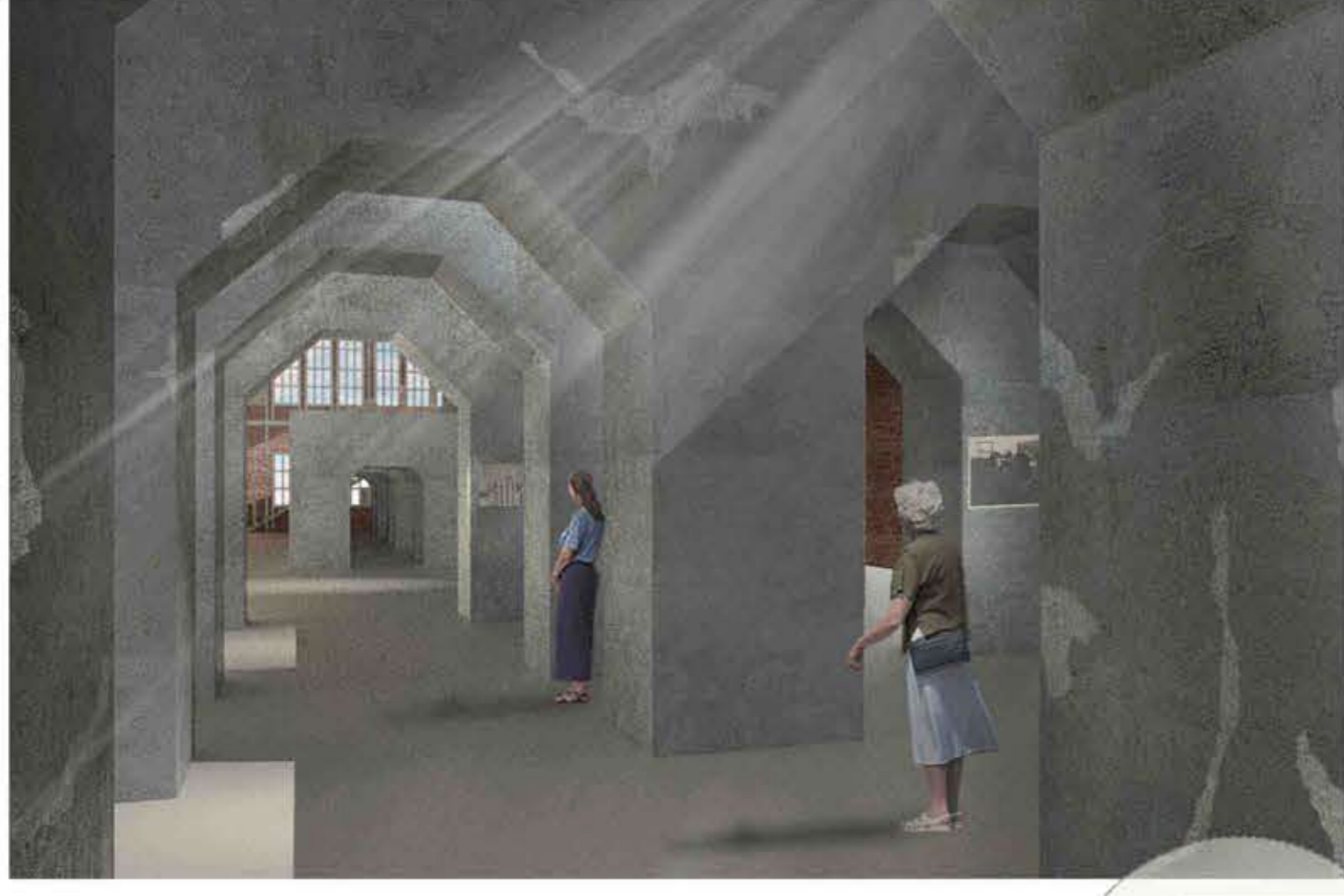
Eskiden makine aksam ve elektrik fiderlerinin olduğu beton bloklar özgün formuyla mekansal bir değer barındırmaktadır. Kırılan yerleri ve çatlakları açık gri beton ile onarılmıştır. Venedik tüzüğü'nün 10. Maddesi referans alınmıştır. Bu bölüm fabrika ile ilgili resim fotoğraf vb. için bir sergi yeri olarak düşünülmüştür.
