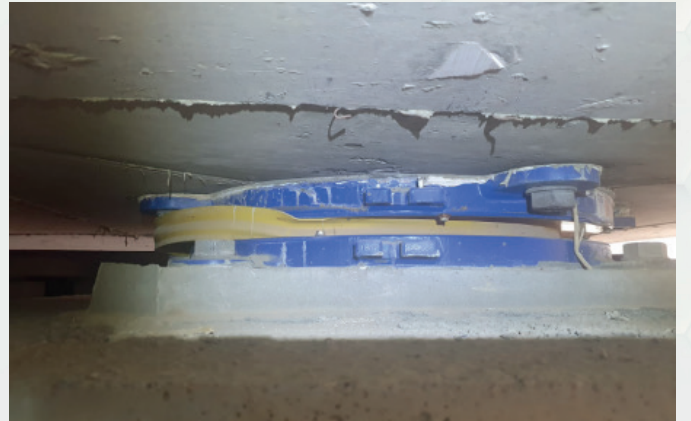
Şekil 3.68. Sismik izolasyonlu Adıyaman EAH binası
