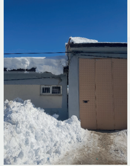
Şekil 3.28. Pınarbaşı Çok Programlı Anadolu Lisesi binası ve kısa kenarlı cephesinde meydana gelen oturma nedeniyle, spor salonu ile arasında ayrılma meydana gelmesi
