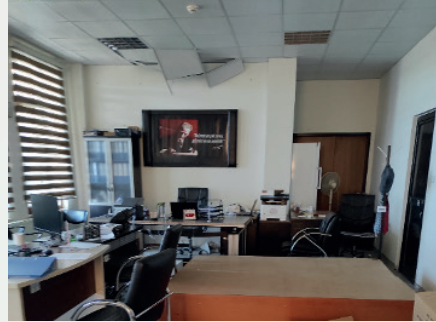
Şekil 3.56. Kalkan duvar düşme tehlikesi ve asma tavan hasarı
