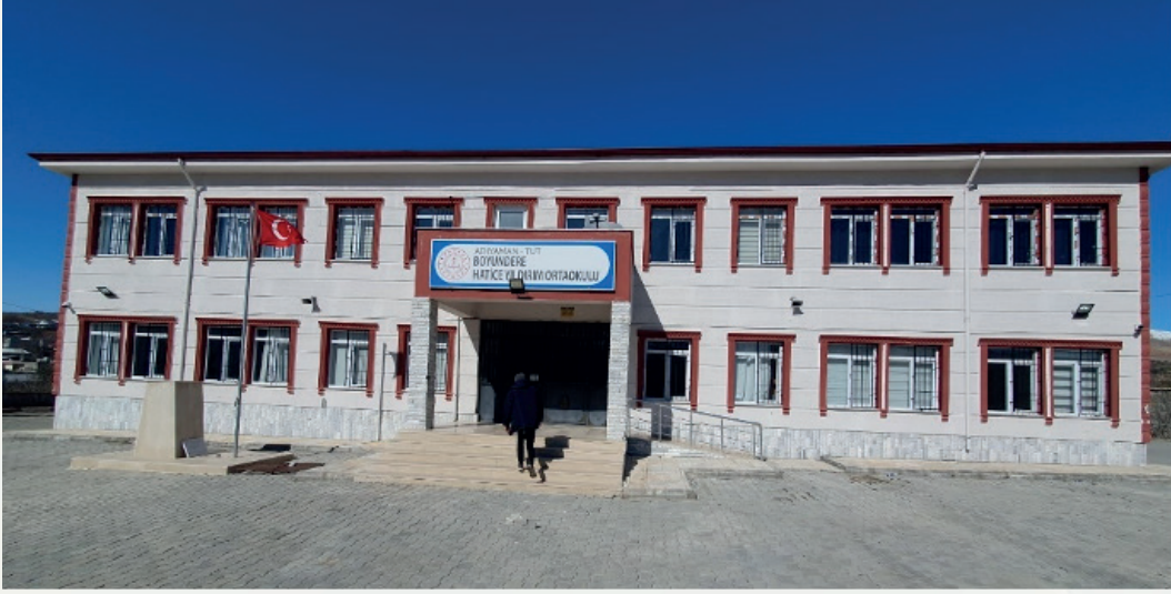
Şekil 3.67. Boyundere Hatice Yıldırım Ortaokul binası
