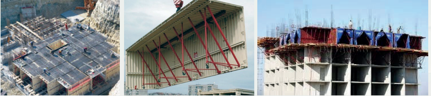
Şekil 4.3. Tünel kalıp sistem ile bina inşaatı
