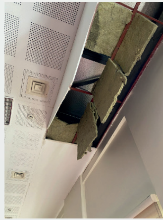
Şekil 3.50. Asma tavan ve bölme duvar hasarları
