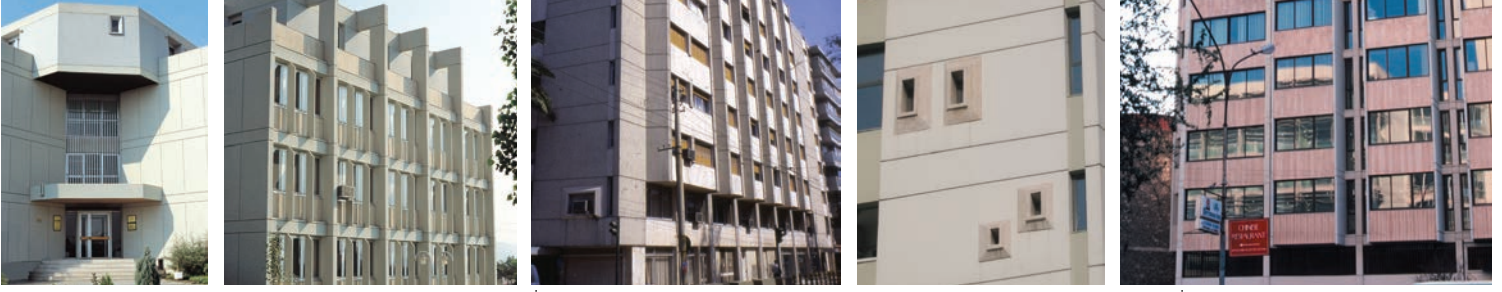
Batı Anadolu Çimento Fabrikası Yönetim Binası, "Güngör Kaftancı Mimarlığı Sergisi", Mimarlar Odası İzmir Şubesi, 2009
