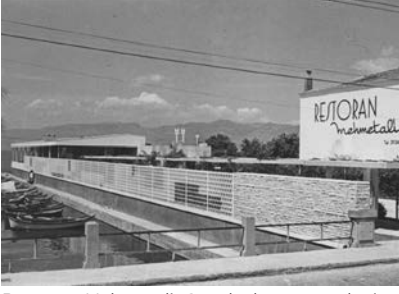
Restoran Mehmetali, Güzelyalı, yapının deniz ile ilişkisi, "Güngör Kaftancı Mimarlığı Sergisi", Mimarlar Odası İzmir Şubesi, 2009
