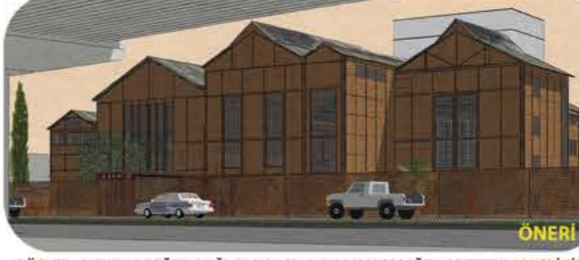
GÖRSEL AKIŞKANLIĞIN SAĞLANMASI ve KAMUSALLIĞIN ARTTIRILMASI İÇİN PERFORE LEVHALAR ÖNERİLMİŞ, YASTIK ETKİSİ YARATMASI İÇİN KORTEN MALZEME TERCİH EDİLMİŞTİR.
