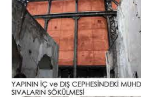
YAPININ İÇ ve DİŞ CEPHESİNDEKİ MUHDES SİYALARIN SÖKÜLMESİ
